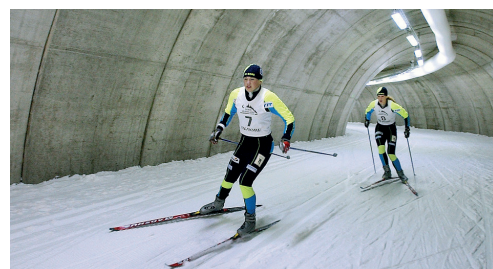
仿真降雪的隧道式越野滑雪道实景
